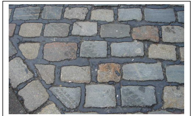
Pflaster mit Fugenverguss
