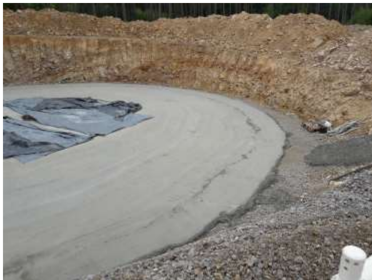
Bilder oben: Fundamentbetonage WEA 1 am 07.08.2019
