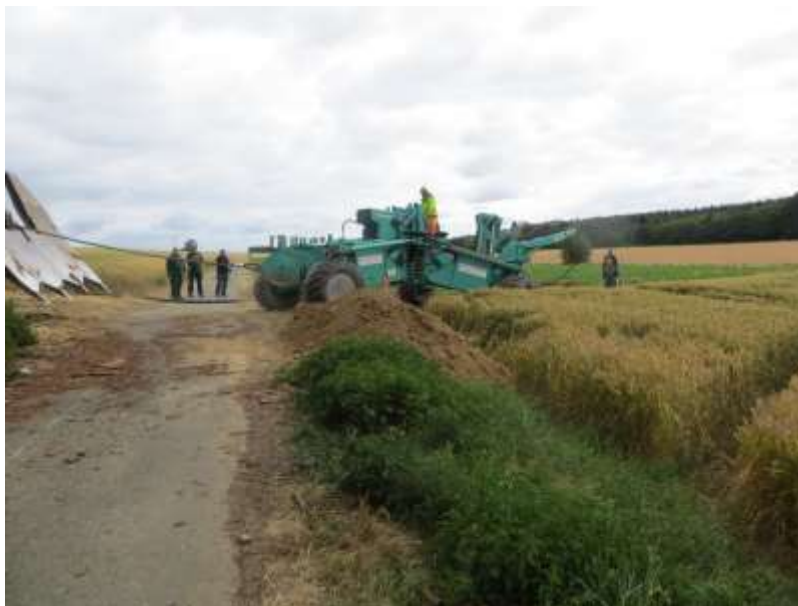
Kabelverlegung mittels Pflug am 09.07.2019 (Pflug am Bildrand links, im Hintergrund Zugmaschine)
