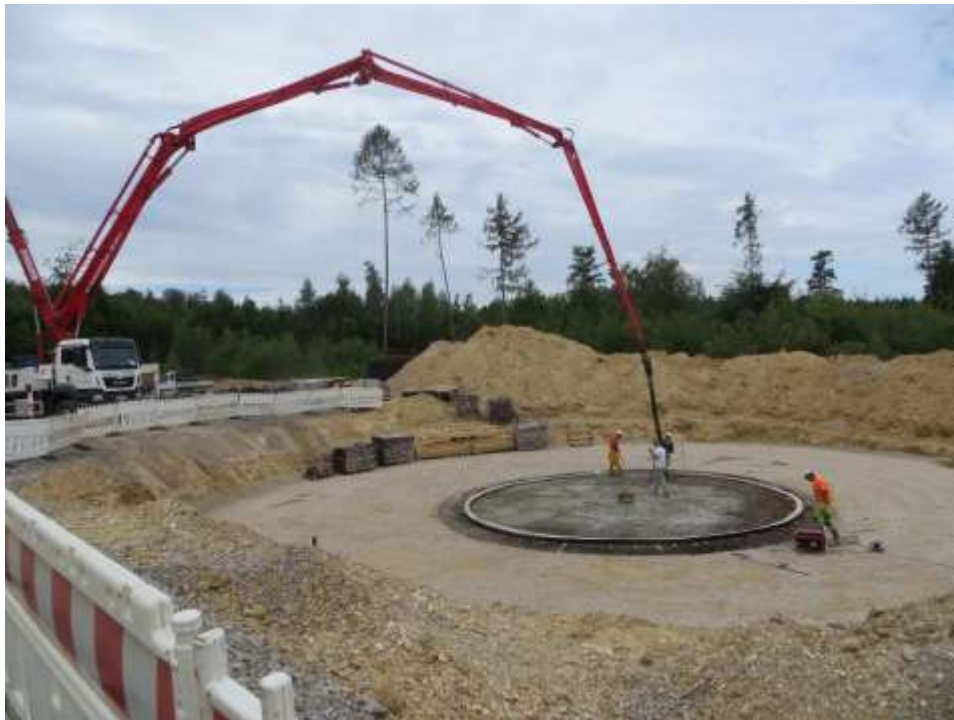
Betonarbeiten am Fundament der WEA 2 am 05.07.2019
