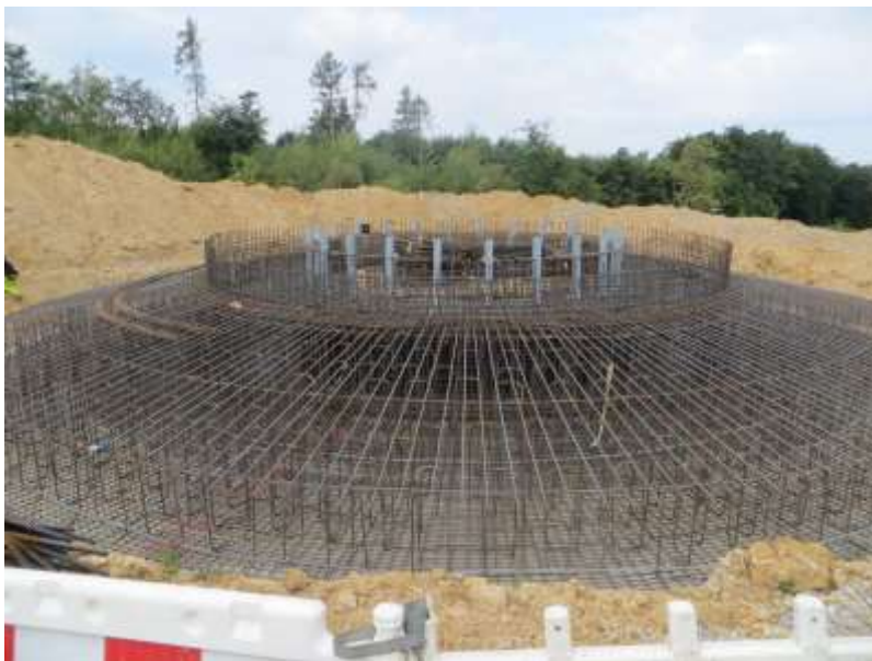
Bewehrung der WEA 2 am 12.07.2019
