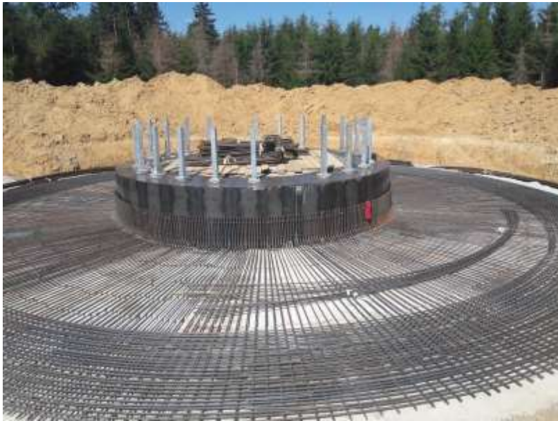
Bewehrung der WEA 1 am 24.07.2019
