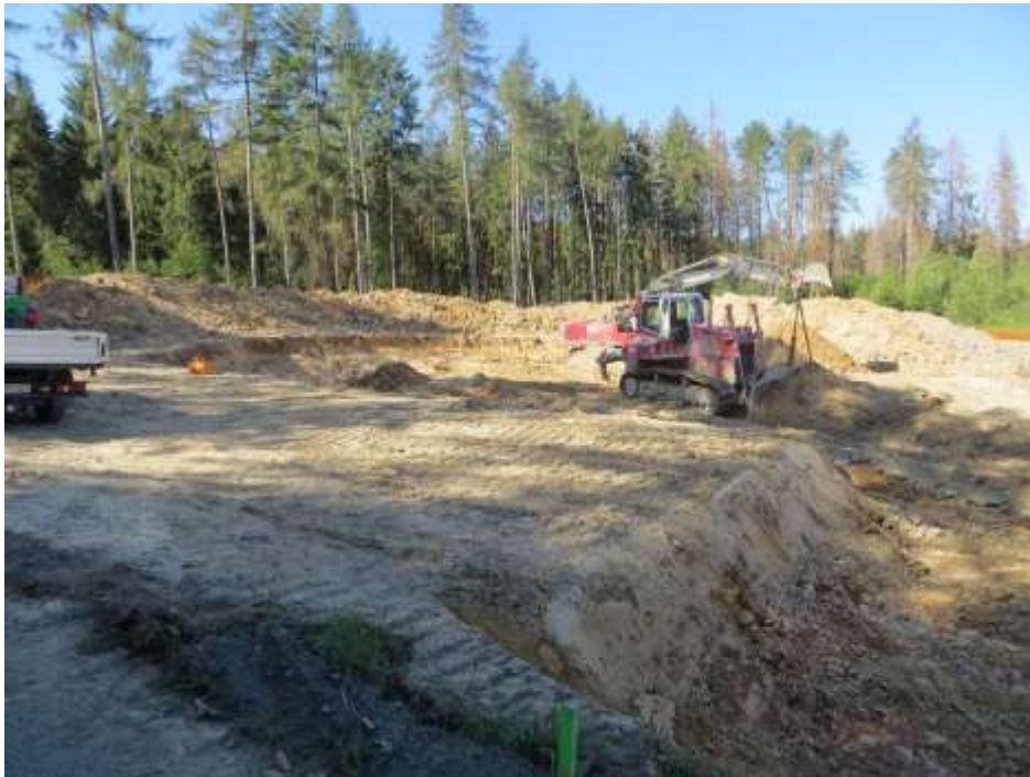
Aushub der Fundamentgrube für WEA 3 am 03.07.2019
