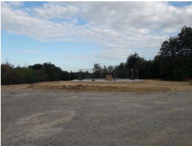
Standort WEA 2 nach Anfüllen des Fundamentes 31.07.2019
