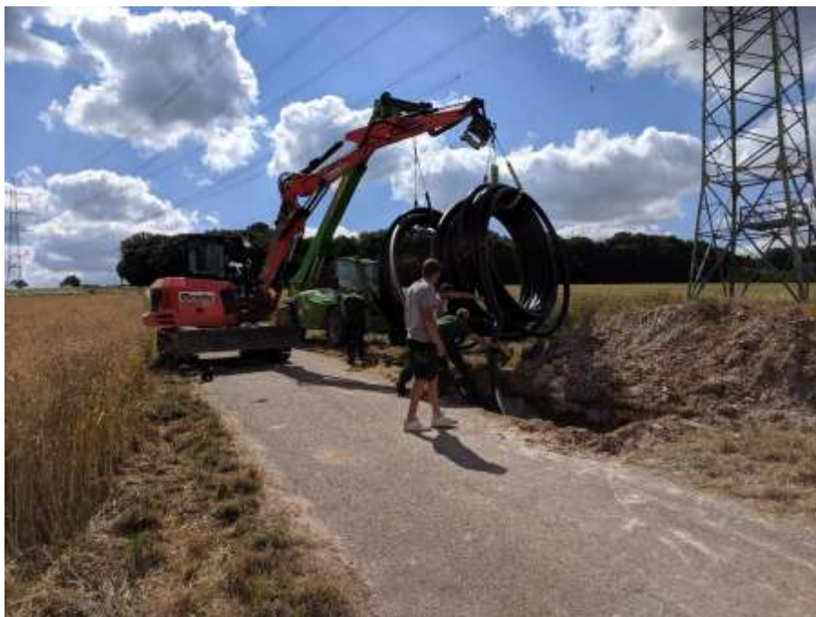
Kabelverlegung an einer Spülbohrung am 02.07.2019.
