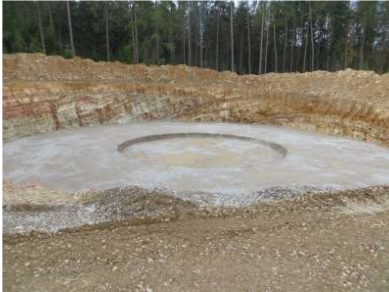
Fundamentgrube WEA 3 am 12.07.2019
