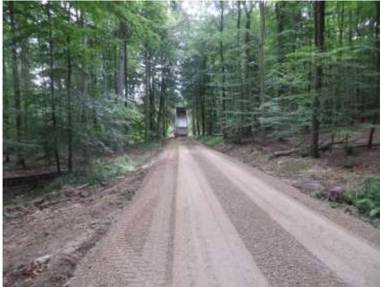
Wegeausbau östliche Zuwegung am 16.08.2019
